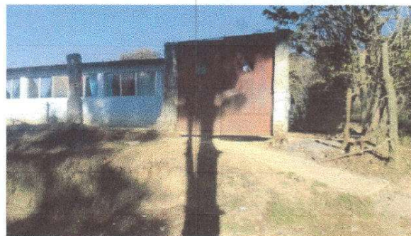
Foto 2: Sustitución de porton de metal
