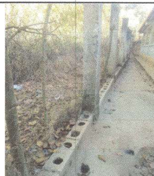
Foto 4: Reparación de muro perimetral de block con tubo hg y malla galvanizada, soleras intermedias y columnas
